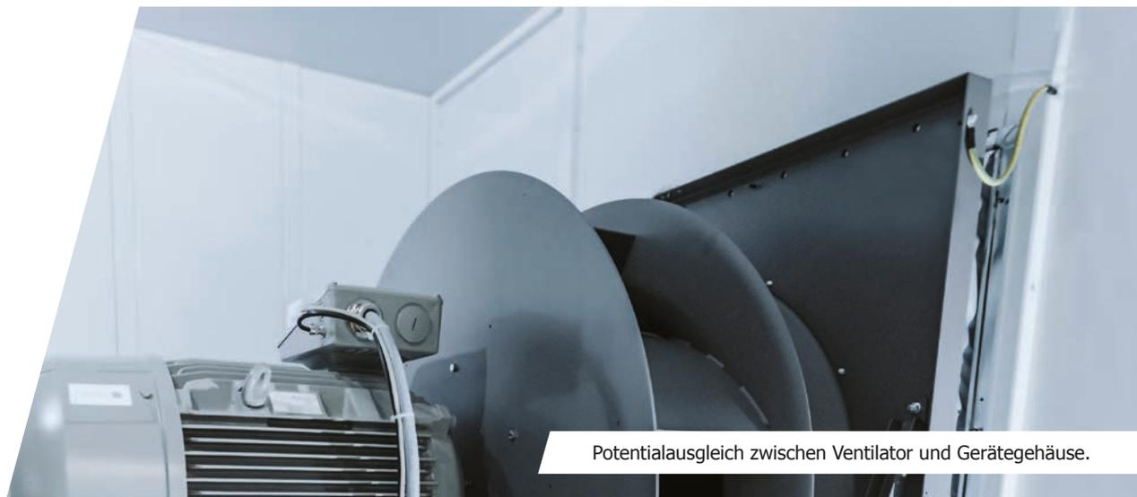
Potentialausgleich zwischen Ventilator und Gerätegehäuse.
