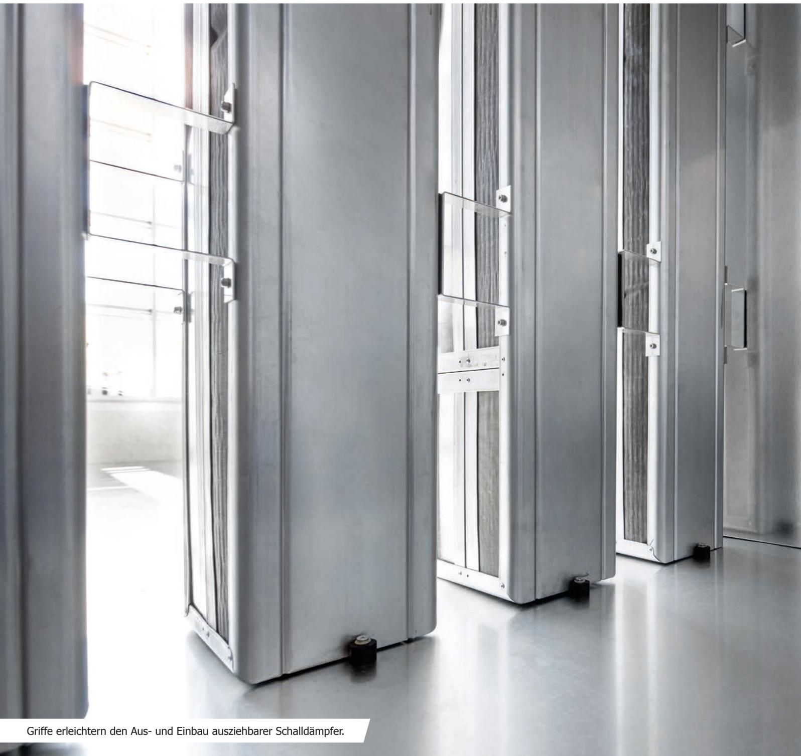
Griffe erleichtern den Aus- und Einbau ausziehbarer Schalldämpfer.
