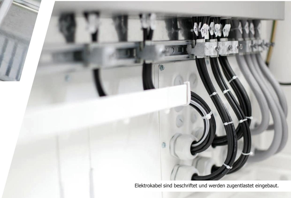
Elektrokabel sind beschriftet und werden zugentlastet eingebaut.
