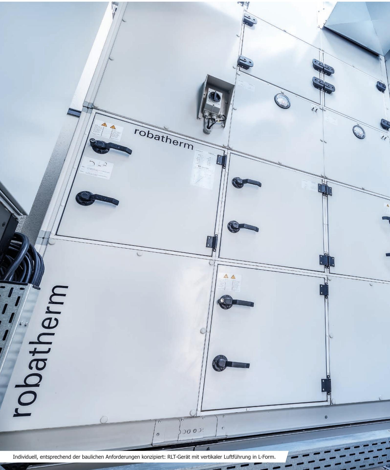
Individuell, entsprechend der baulichen Anforderungen konzipiert: RLT-Gerät mit vertikaler Luftführung in L-Form.
