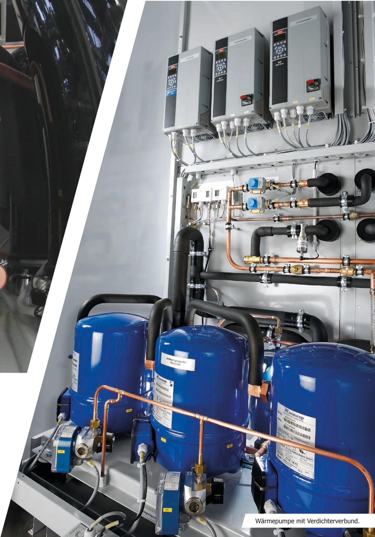
Wärmepumpe mit Verdichterverbund.
