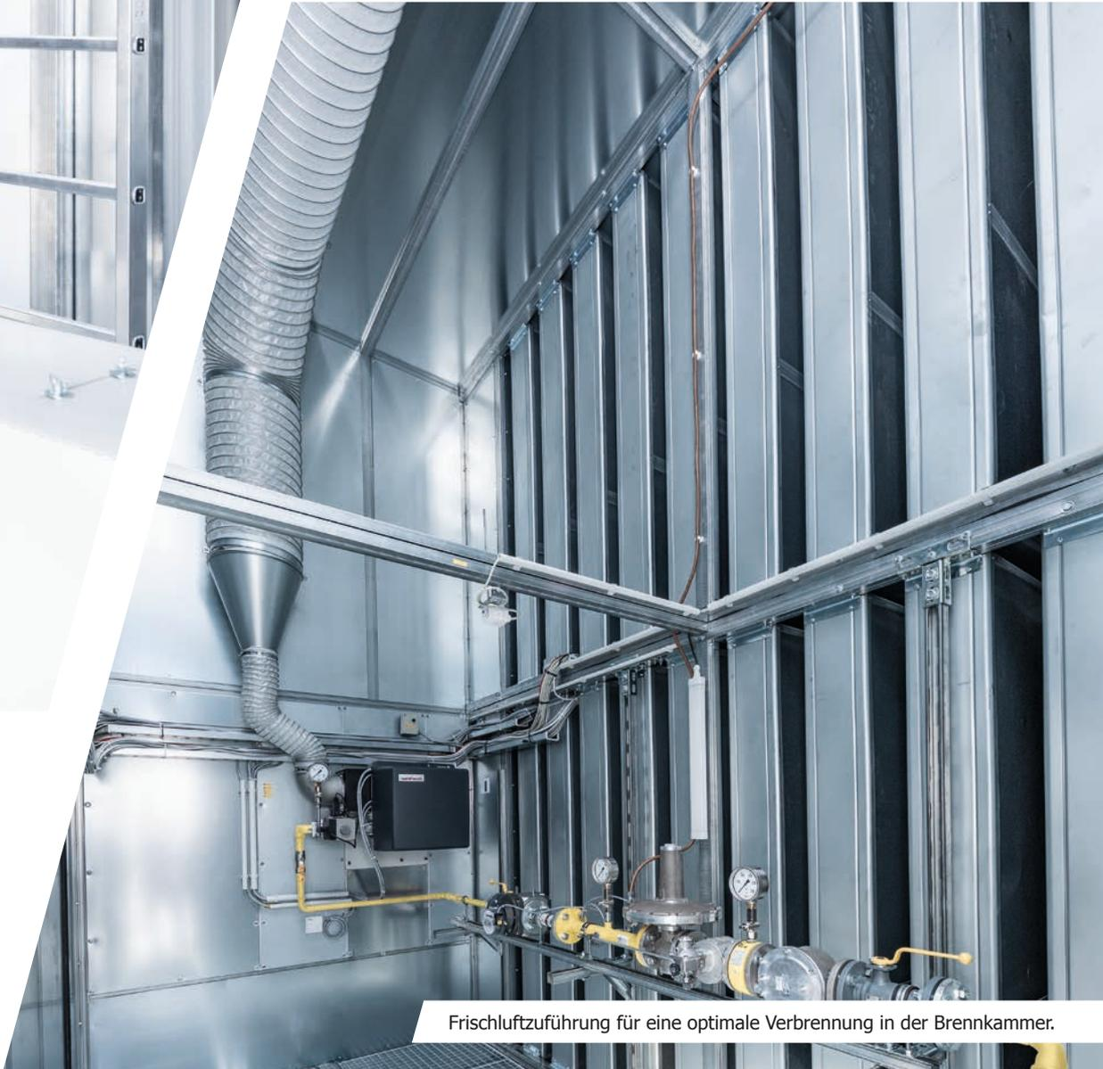
Frischlufzuführung für eine optimale Verbrennung in der Brennkammer.
