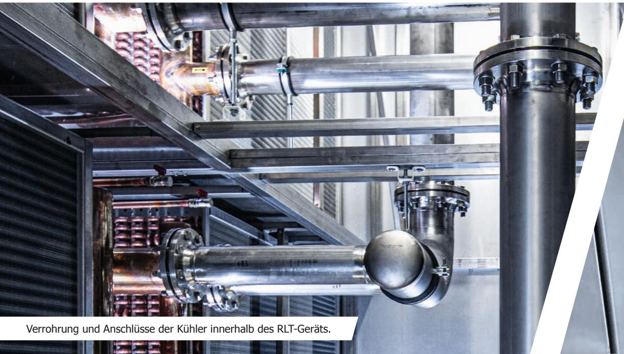
Verrohrung und Anschlüsse der Kühler innerhalb des RLT-Geräts.
