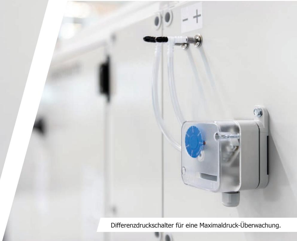
Differenzdruckschalter für eine Maximaldruck-Überwachung.
