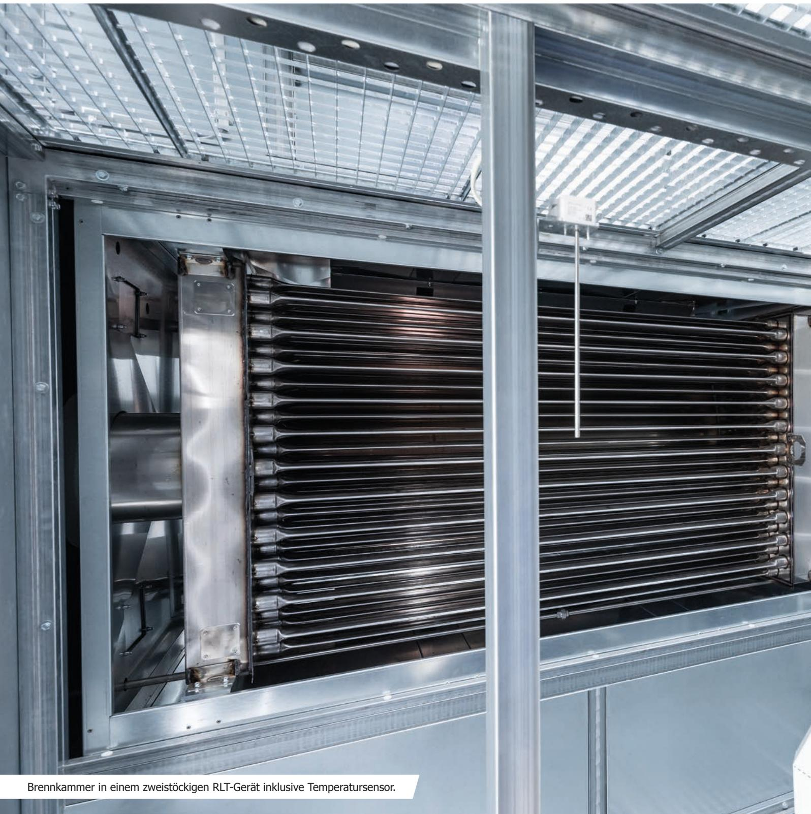
Brennkammer in einem zweistöckigen RLT-Gerät inklusive Temperatursensor.
