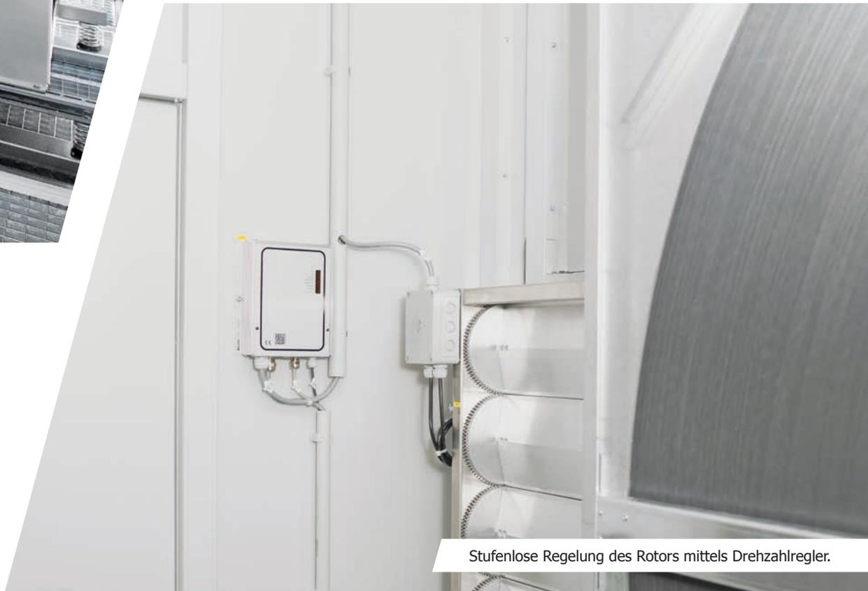
Stufenlose Regelung des Rotors mittels Drehzahlregler.
