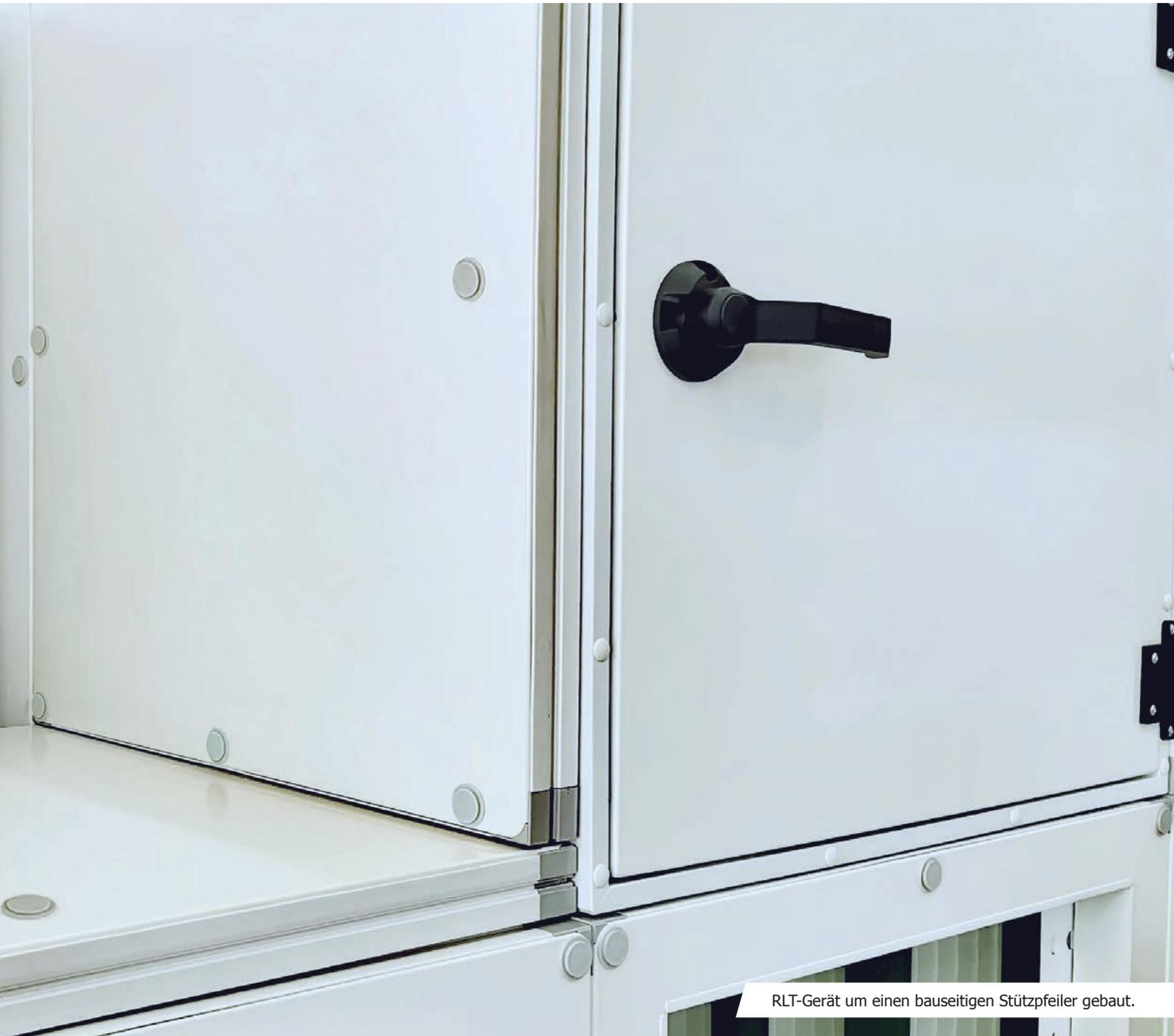
RLT-Gerät um einen bauseitigen Stützpfiler gebaut.
