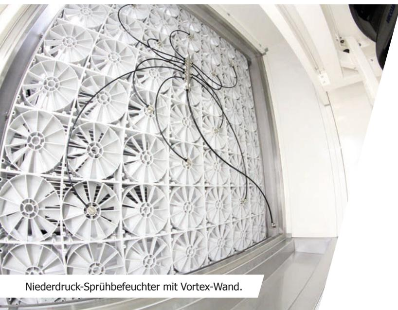
Niederdruck-Sprühbefeuchter mit Vortex-Wand.
