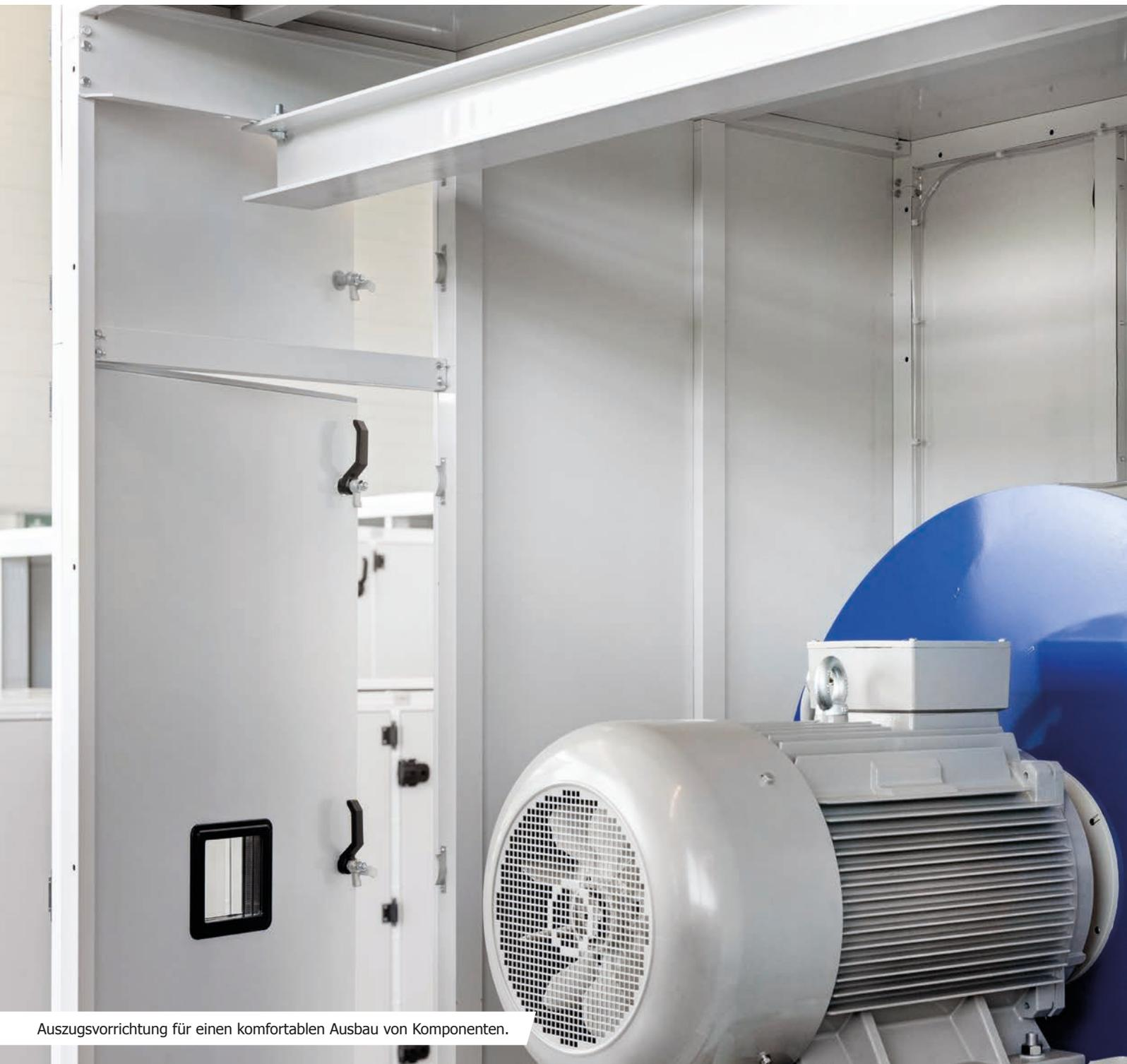
Auszugsvorrichtung für einen komfortablen Ausbau von Komponenten.
