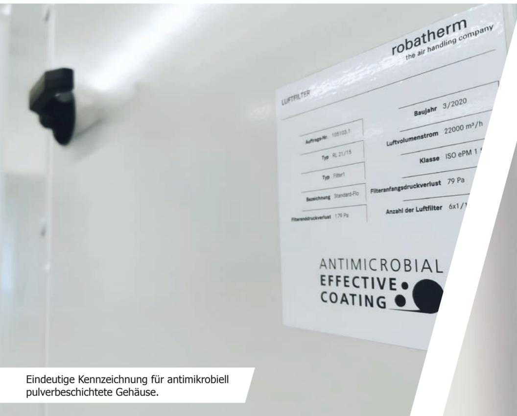
Eindeutige Kennzeichnung für antimikrobiell pulverbeschichtete Gehäuse.
