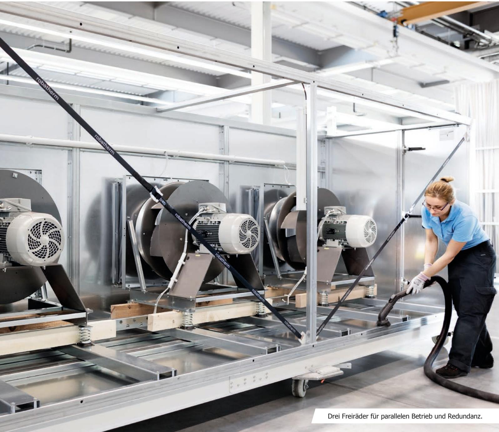
Drei Freiräder für parallelen Betrieb und Redundanz.
