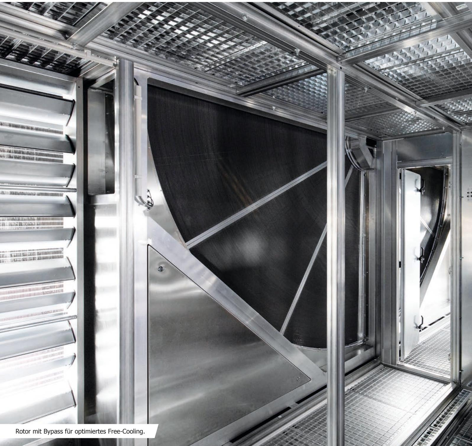
Rotor mit Bypass für optimiertes Free-Cooling.
