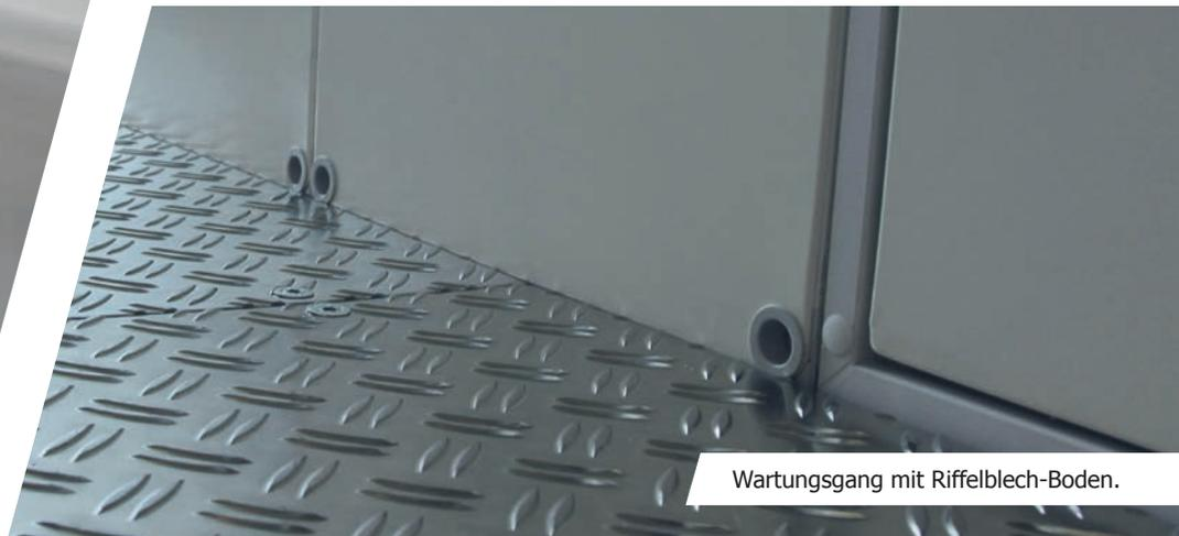
Wartungsgang mit Riffelblech-Boden.
